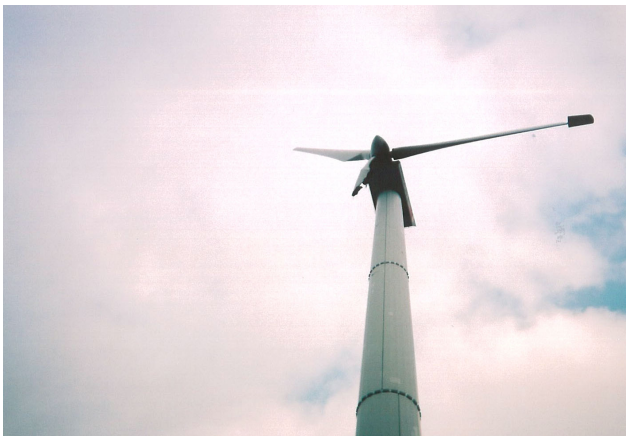
図4 焼損したブレード部
