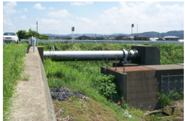
写真 - 2.2 A1橋台
