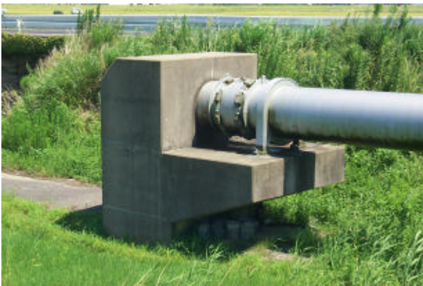
写真 - 2.1 A2橋台
